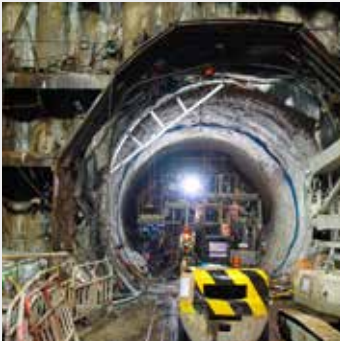
A infraestrutura de engenharia, como este túnel subterrâneo do metrô, é essencial para o desenvolvimento sustentável. © Mr Pung Chun Nok, Hong Kong Institution of Engineers
